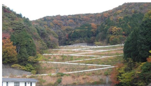
三原市一般廃棄物最終処分場
