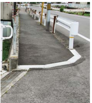
▲歩道の段差を解消しました
