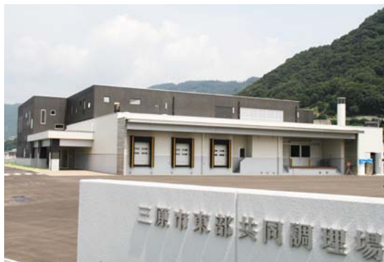
▲糸崎九丁目の埋め立て地内に完成した東部共同調理場
