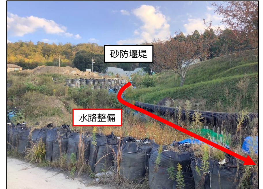
※砂防堰堤の流末水路整備
