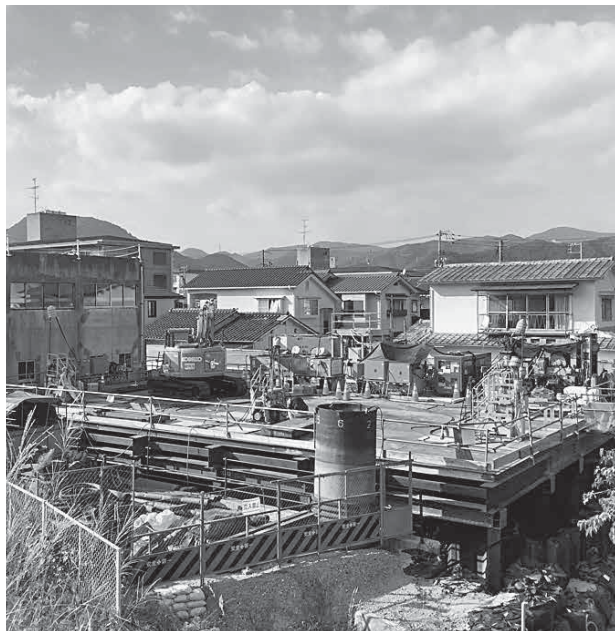
改修工事中の皆実ポンプ場
