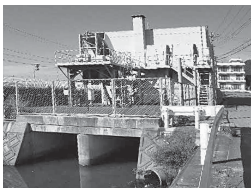
味濁ポンプ場
