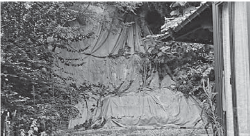
裏山が崩れた民家
