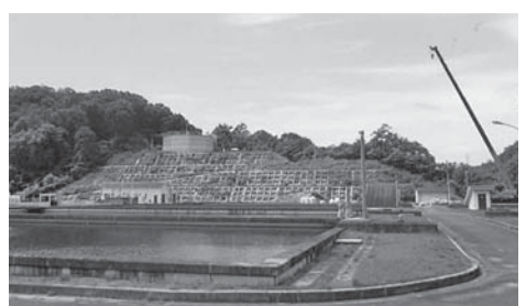
おいしい三原の水をつくっている西野浄水場
