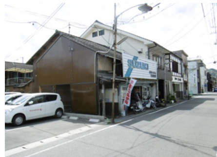
4寸勾配程度の屋根で平入り（手前の2棟）。3棟が調和し、まちなみのイメージを高めています。両側は妻入り
