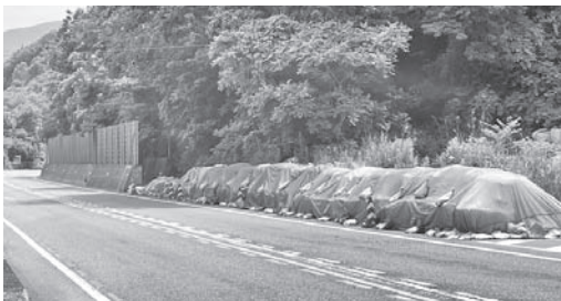
土石流危険のある処分場入口の防護壁
