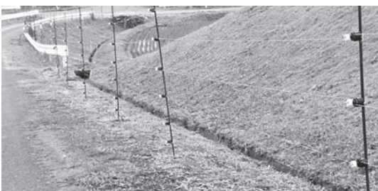
市道の路肩に設置された電気柵（侵入防護柵）
