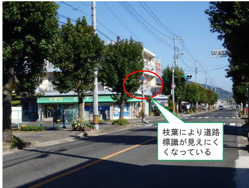
信号機や歩行者、標識等が隠されるなど、交通安全上の支障
