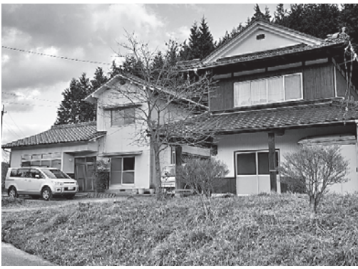
空き家活用した家（三次からターン）
