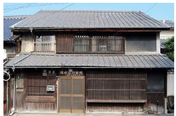
▲改修前の古民家しみず(本町3丁目)
