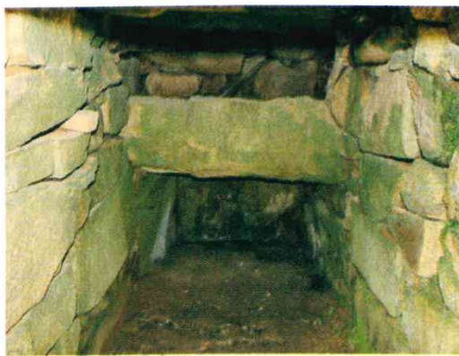
▲石室の奥に1枚石が横に架けてあり、棚のようにしている
