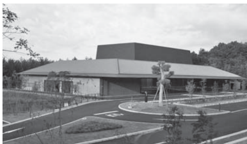
完成した新斎場
