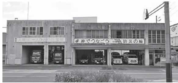
消防署西部分署
