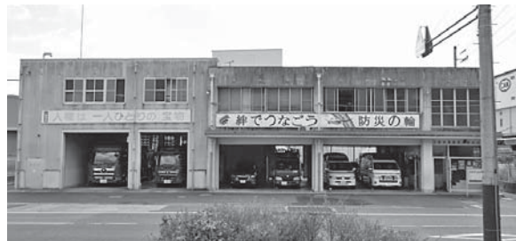
消防署西部分署
