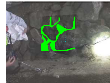
ハッチ部は空隙を示す。間隙率=24.2%
