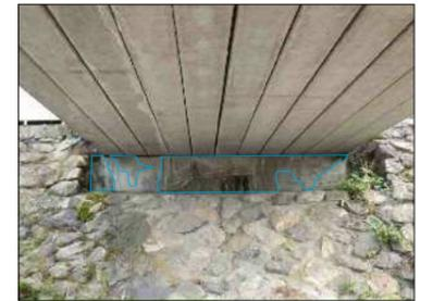
伸縮装置からの漏水が橋台前面に生じている
