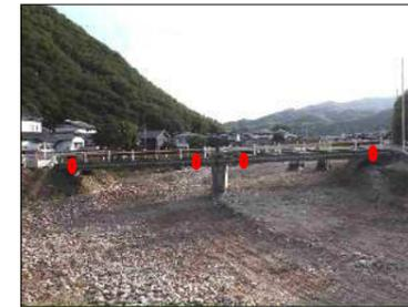
排水管路末部の欠損に伴い、側面に伝い水痕が確認される
