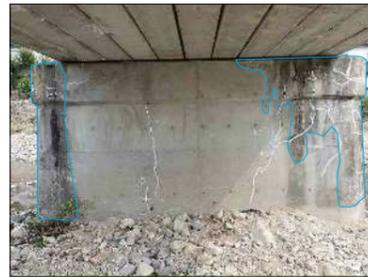
伸縮装置からの漏水が橋脚正面に生じている
