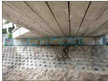
伸縮装置からの漏水が橋台前面に生じている
