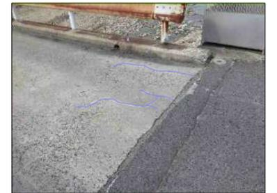
コンクリート舗装全体に経年疲労に伴う軽微なひびわれが生じている
