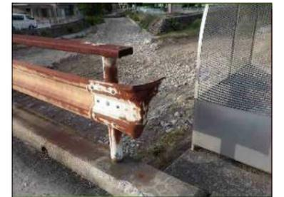
ガードレール端部に変形が生じている
