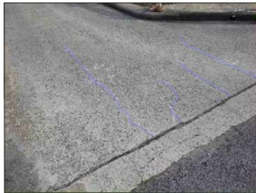
コンクリート舗装全体に経年疲労に伴う軽微なひびわれが生じている
