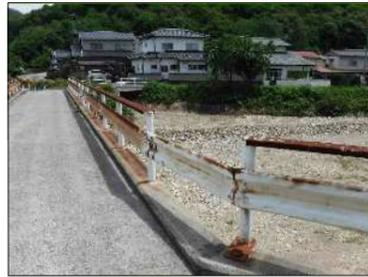
ガードレールの笠木に局部的な欠損が生じている
