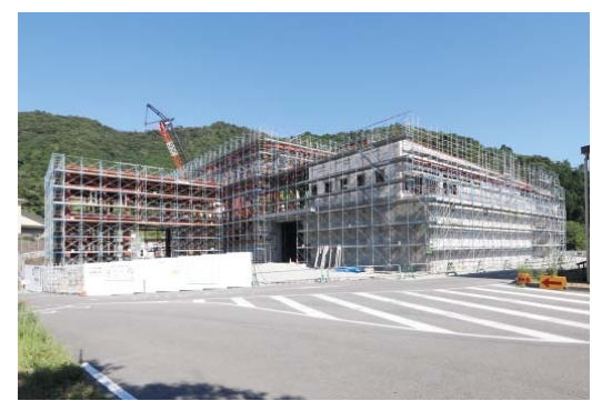
▲建設中の不燃物処理工場(8月15日現在)
