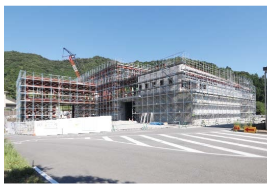
▲建設中の不燃物処理工場(8月15日現在)
