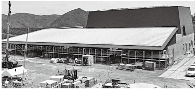
建設中の新斎場
