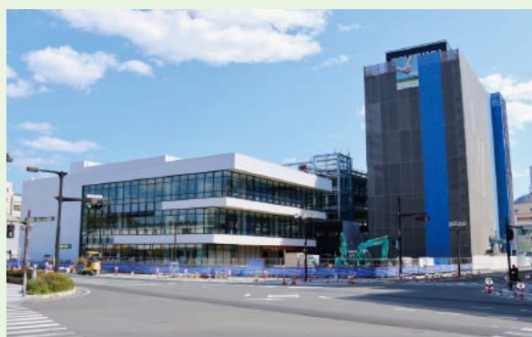
▲整備が進む駅前東館跡地
