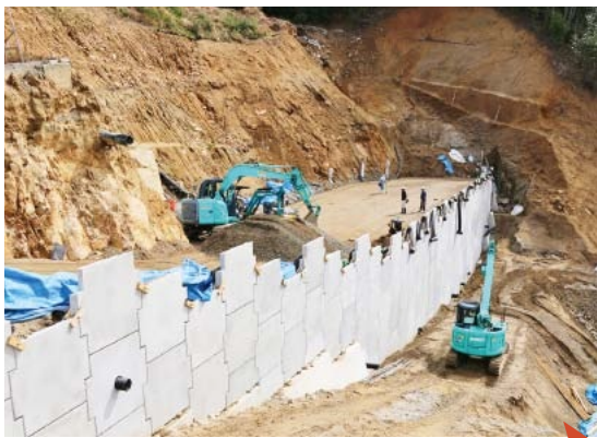
▲復旧工事が進む市道本郷町日山地用倉線
