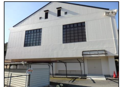
改修後の大ホール外壁
