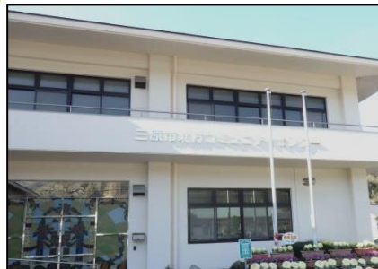
改修後の本館外壁
