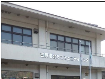
改修前の本館外壁
