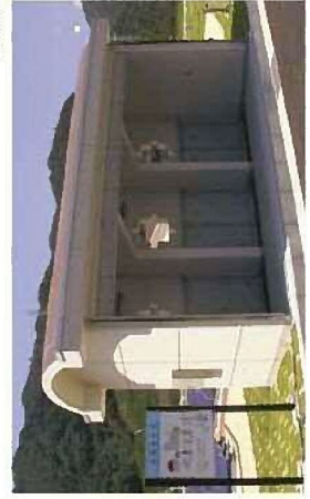
応急給水所 給水口 φ75mm 2栓 φ13mm 6栓
