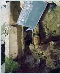
銅鉄管φ150耗 銅折れ破損 水崎町県道永崎港線
