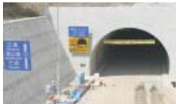
完成に向け工事が進む三原バイパス
