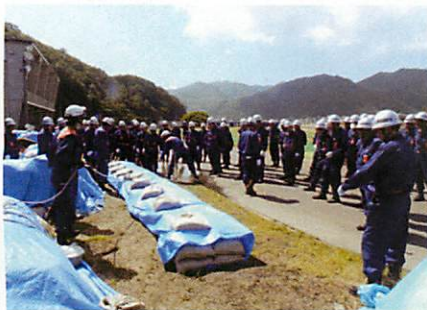
積み土のう(改良型)工法
