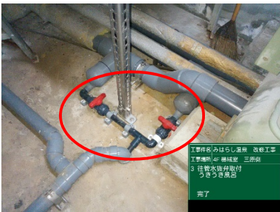
ジェット循環配管水抜弁取付
