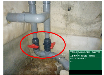
水位計管水抜弁取替
