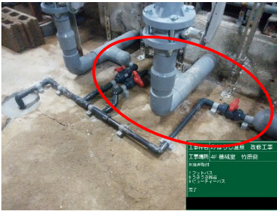
ジェット循環配管水抜弁取付
