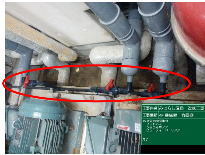
ジェット循環配管水抜弁取付
