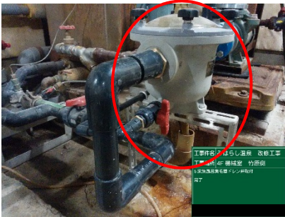
集毛器取替・水抜弁取付(家族風呂)
