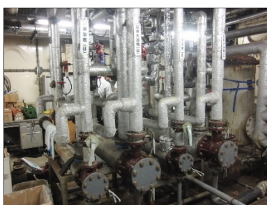
温泉系統熱交換器
