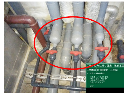
ジェット循環配管水抜弁取付
