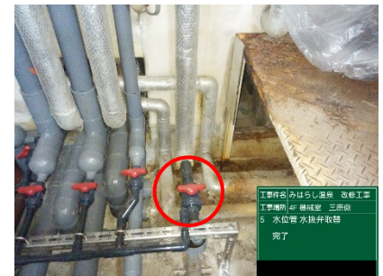
水位計管水抜弁取替
