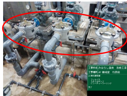
集毛器取替・水抜弁取付(ジェット循環)
