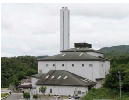
▲稼働から17年が経過し、建築物などが老朽化している清掃工場
