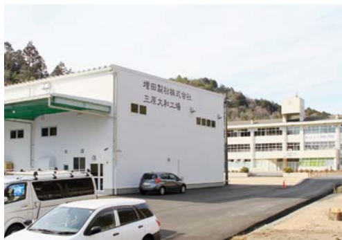
▲旧神田小跡地に建設中の製粉工場。旧校舎には地元の加工事業者が入居
