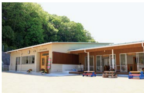
▲完成した西幼稚園の園舎
