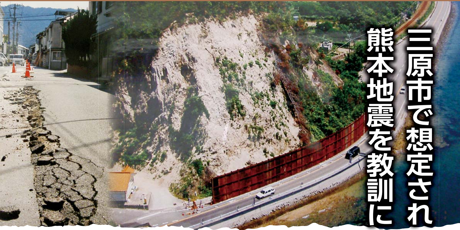
▲平成13年の芸予地震で被害を受けた三原市内。道路のひび割れ、斜面の崩落も起きました。
