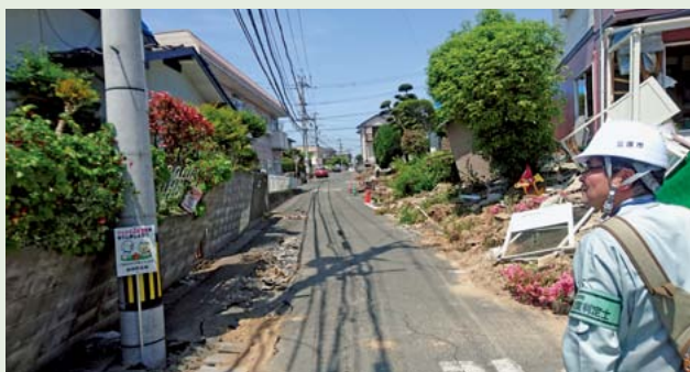
▲住宅の応急危険度判定作業に当たる職員(写真上・下)
