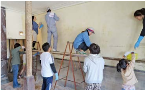
▲市内で増えている空き家を有効活用するための調査を実施(写真は市民団体による古民家再生のようす)
