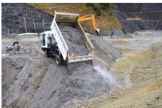
▲最終処分場を延命化するため、ごみの焼却灰などを県の処分場へ搬出
