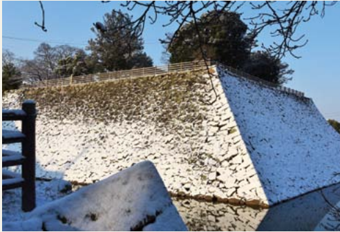
雪の三原城跡 撮影者 船本雄三さん 撮影日 平成28年1月 撮影場所 三原城跡 (館町一丁目)
