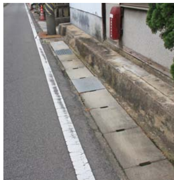
▲老朽化した側溝ぶたを交換しました
