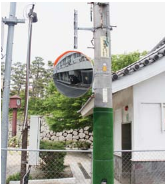
▲交通量の多い三叉路にカーブミラーを設置
