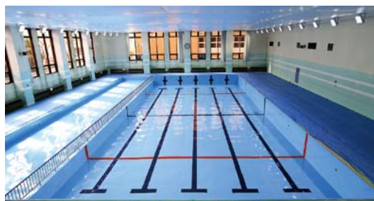
▲工事完了を間近に控えた温水プール
