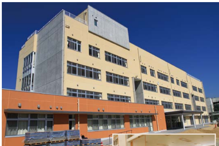
▲南小学校校舎棟
