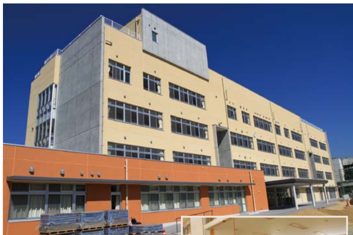
▲南小学校校舎棟
