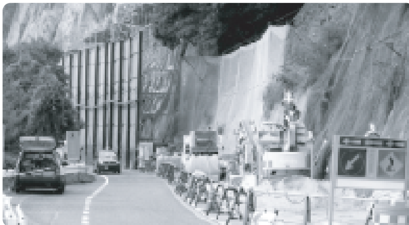
崩落防止工事中の恵下谷
