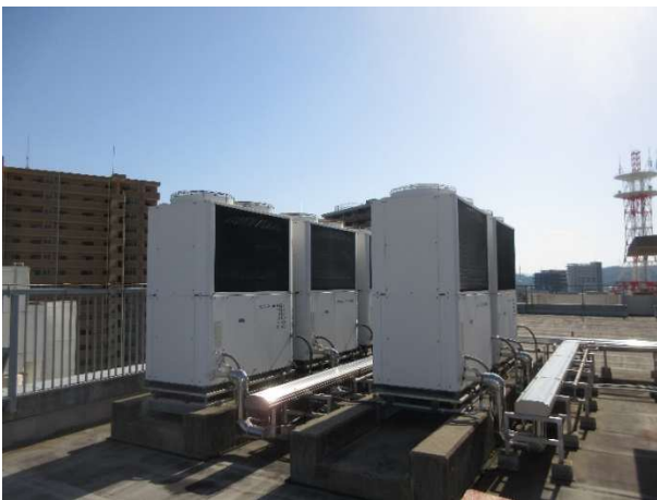
画像7 空調ダクト
