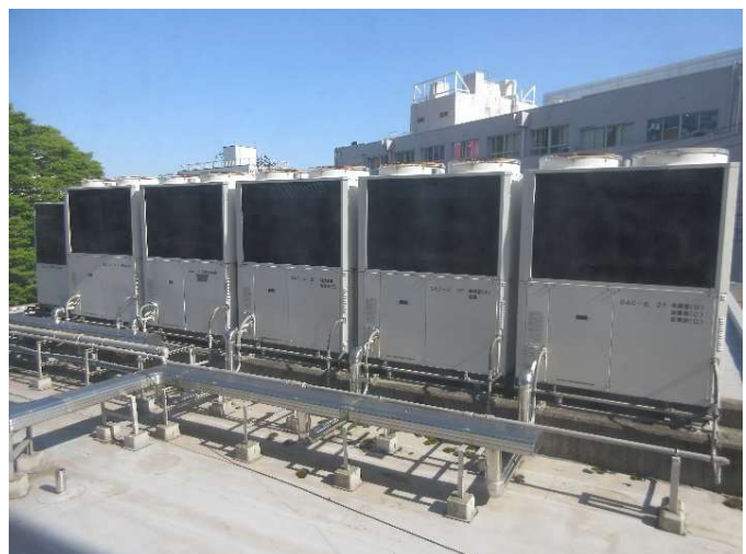
画像5 空調ダクト
