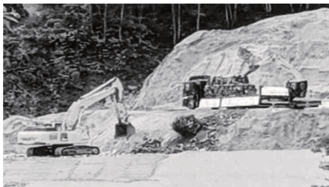
本郷産廃処分場への搬入状況
