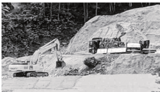
本郷産廃処分場への搬入状況
