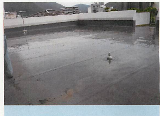
状況・コメント: 防水状況
