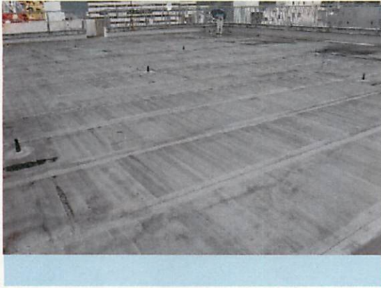
状況・コメント：防水状況
