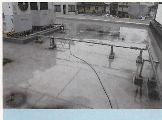
状況・コメント: 防水状況
