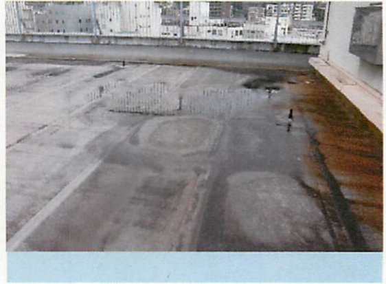
状況・コメント：防水状況
