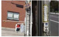
音響式信号機 交 通 弱 者 用 押しボタン式信号機
