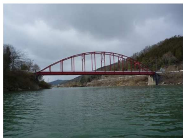
中央大橋 L=80.2m(鋼橋) 1969年架設
