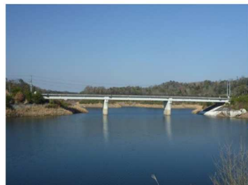
三河橋 L=106.0m(PC橋) 1999年架設
