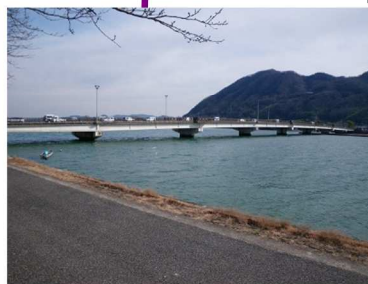
沼田大橋 L=316.0m(PC橋) 1996年架設
