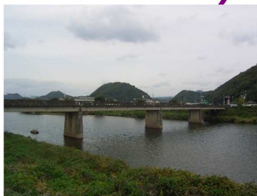
本市橋 L=110.0m(PC橋) 1964年架設
