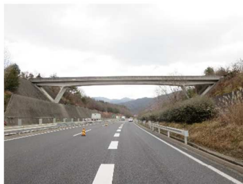
仏通寺橋 L=69.2m(PC橋) 1993年架設
