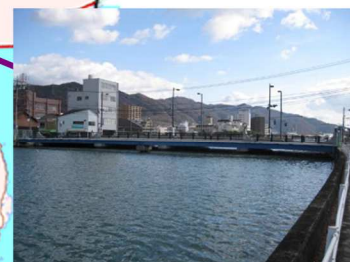
曙橋 L=52.9m(PC橋) 1999年架設
