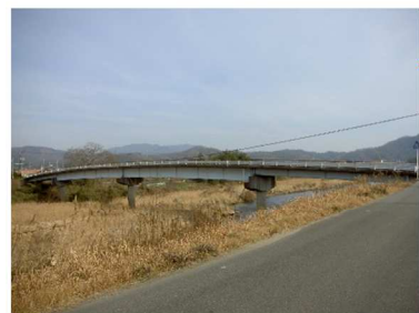
船木大橋 L=102.6m(鋼橋) 1970年架設
