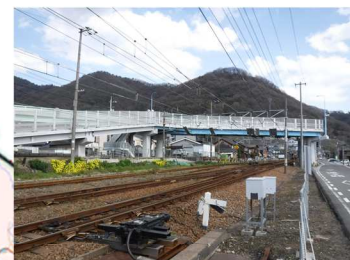
糸崎122号線3号橋梁 L=118.0m(PC橋) 1963年架設
