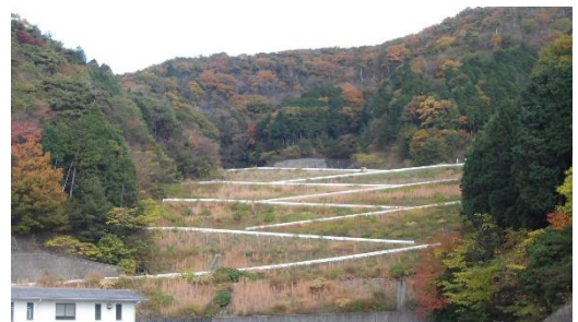
三原市一般廃棄物最終処分場
