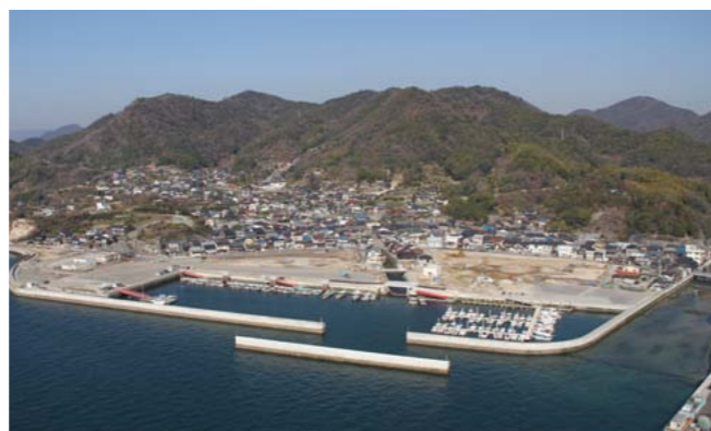
▲道路整備や宅地造成などを行う幸崎能地漁港
