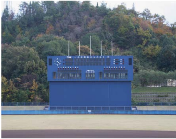
▲スコアボードを中心に老朽化した市民球場を改修
